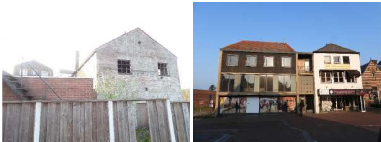
Detailopname van de te slopen bebouwing.
