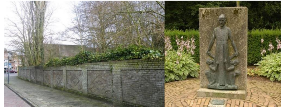
Het Ariënsmonument (rechts) en delen van de tuinmuur dienen terug te komen en ingepast te worden in het openbaar gebied
