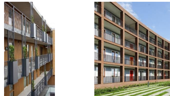
Gevels galerijen mee ontwerpen en opnemen in de architectuur
