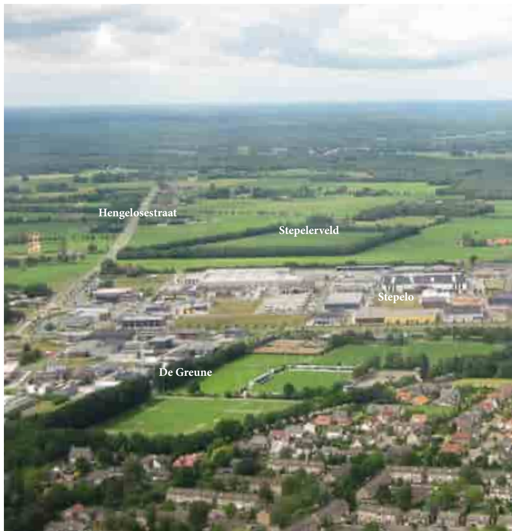
Haaksbergen, richting het noordoosten, met hierboven de bestaande bedrijventerreinen de Greune en Stepelo, de locatie van het geplande bedrijventerrein Stepelerveld en de spoorlijn (rechts)
