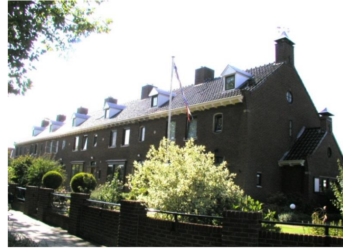
Lintbebouwing aan de Goorsestraat
