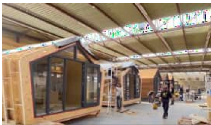
Referentie van prefab verplaatsbare woningen
