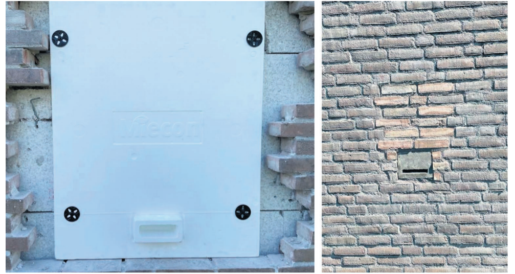
Hierboven een voorbeeld van een vleermuiskast die wordt ingebouwd in de spouwmuur.
